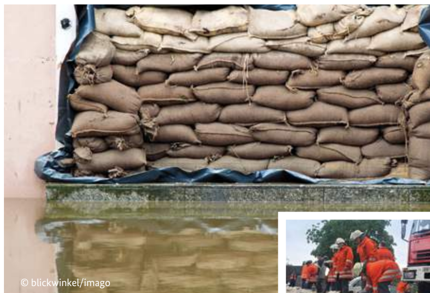
Remparts de protection avec des sacs de sable
