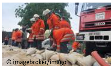
Remparts de protection avec des sacs de sable
