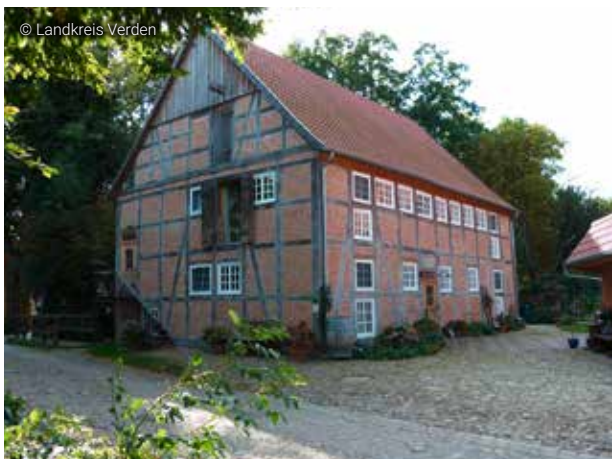
Sanierte Wassermühle in Fischerhude
