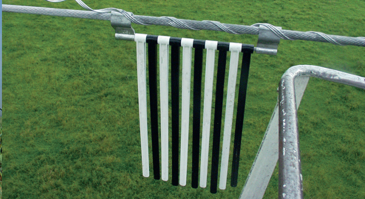
Vogelschutzmarkierung an einem Erdseil
