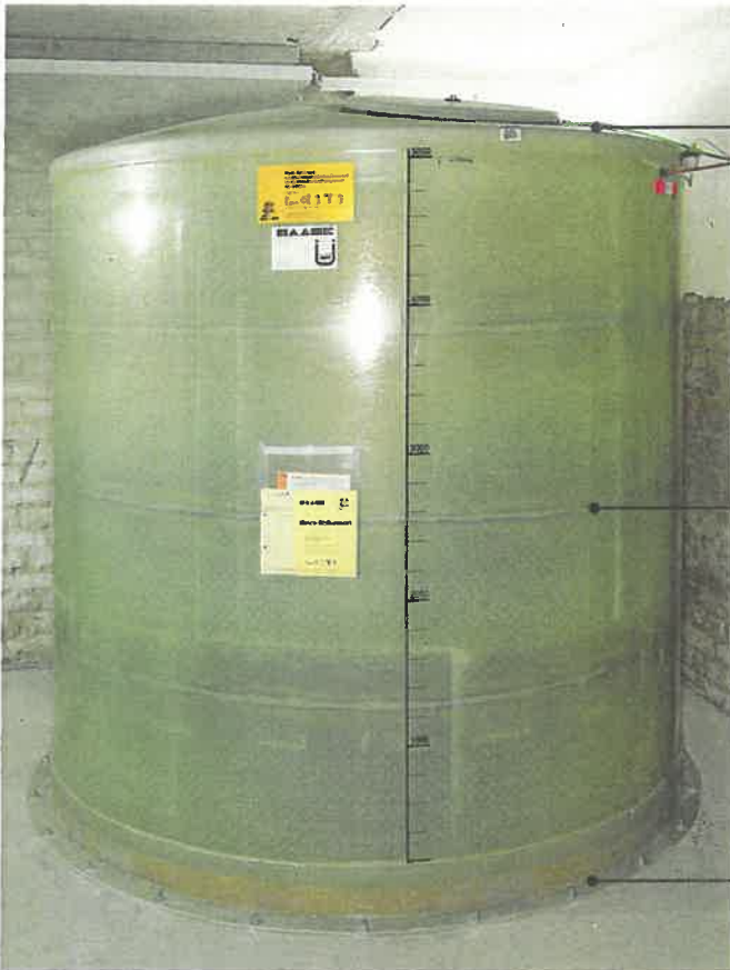
Abbildung 12: Auftriebsicherung bei standortgefertigtem GFK-Öltank
