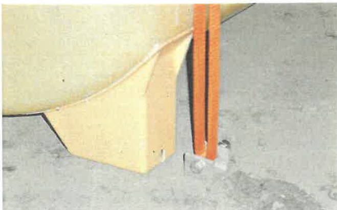
Abbildung 18: Hochwassersichere Aufstellung (Bsp. Fa. CEMO)
