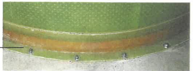
Detail: Verankerung des verstärkten Bodens im Beton
