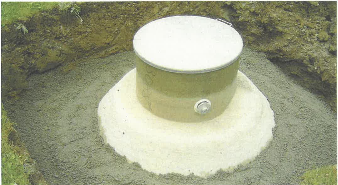
Abbildung 4: Auftriebsicherung unterirdischer Öltank (GFK-Tank)
